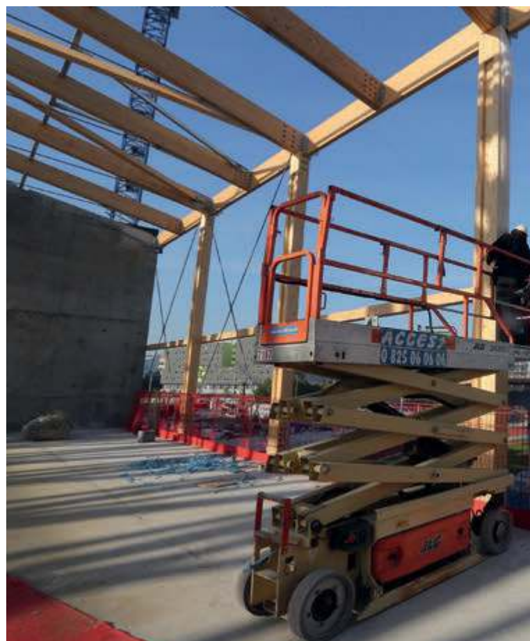
Chantier du futur lycée de l'île de Nantes.
