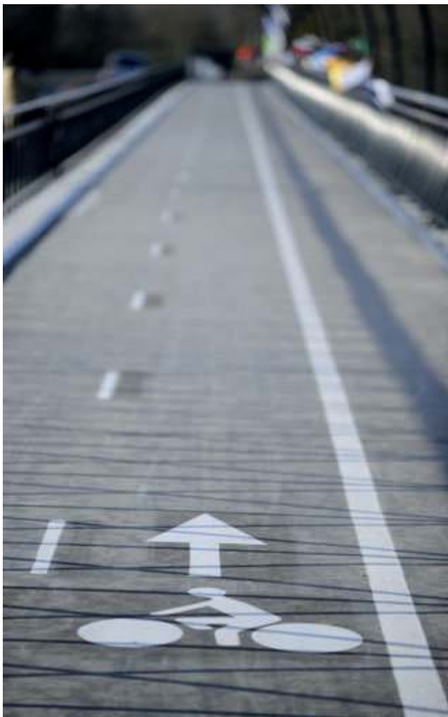
Voies piétonnes et deux roues du pont de la Jonelière, Nantes.
