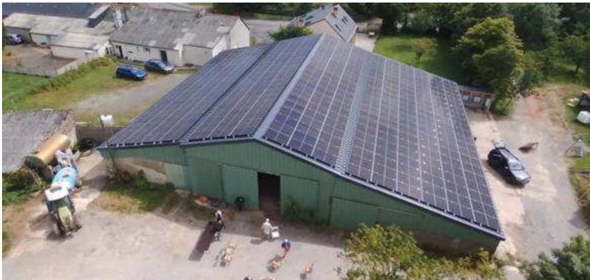
La centrale photovoltaïque de Bourg Louet à Saint-Herblon (44) est construite sur la toiture d'un bâtiment agricole avec deux pentes orientées Est et Ouest.
